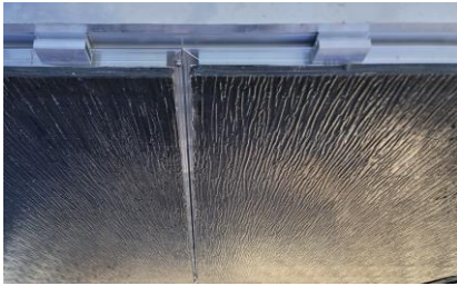
[Z-Bar 모듈프레임 및 Clip 고정스터드 알루미늄 프레임]
