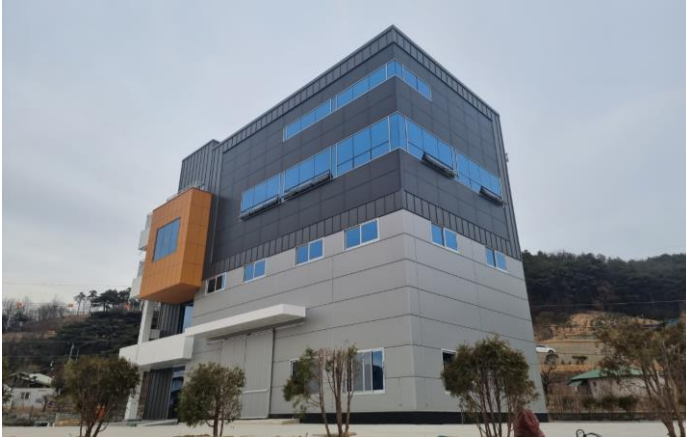
세종시 _ Solwall 20Kw
