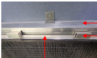
[Z-Bar 모듈프레임 및 Clip 고정스터드 알루미늄 프레임]
