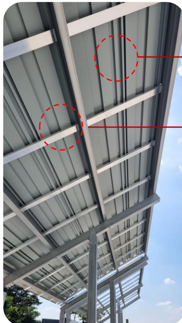
[강판 절곡 구조 및 PV 모듈과 일체형으로 접합, 알루미늄 고정스터드]
