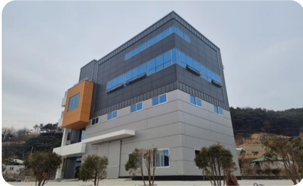
세종시 _ Solwall 20Kw
